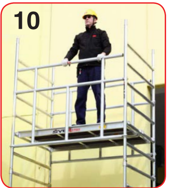
Una volta montato il piano la ringhiera di protezione di 1 m è già pronta in opera
