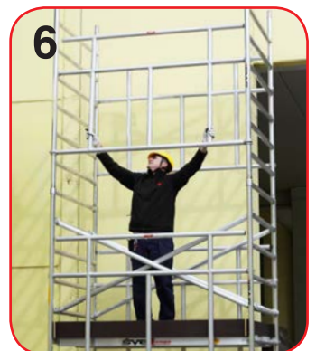
Una volta montato il piano la ringhiera di protezione di 1 m è già pronta in opera
