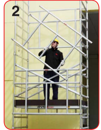
Il parapetto SAFE è in alluminio leggero e facile da maneggiare
